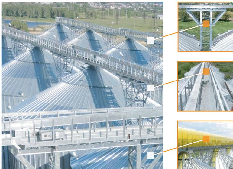
Для загрузки силосов **ИСПОЛЬЗУЮТСЯ ТРАНСПОРТНЫЕ СИСТЕМЫ, РАСПОЛОЖЕННЫЕ НА ГАЛЕРЕЯХ С ОПОРНЫМИ КОНСТРУКЦИЯМИ**
