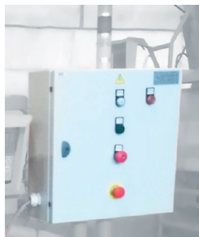
Стационарный пульт управления системами агрегата
