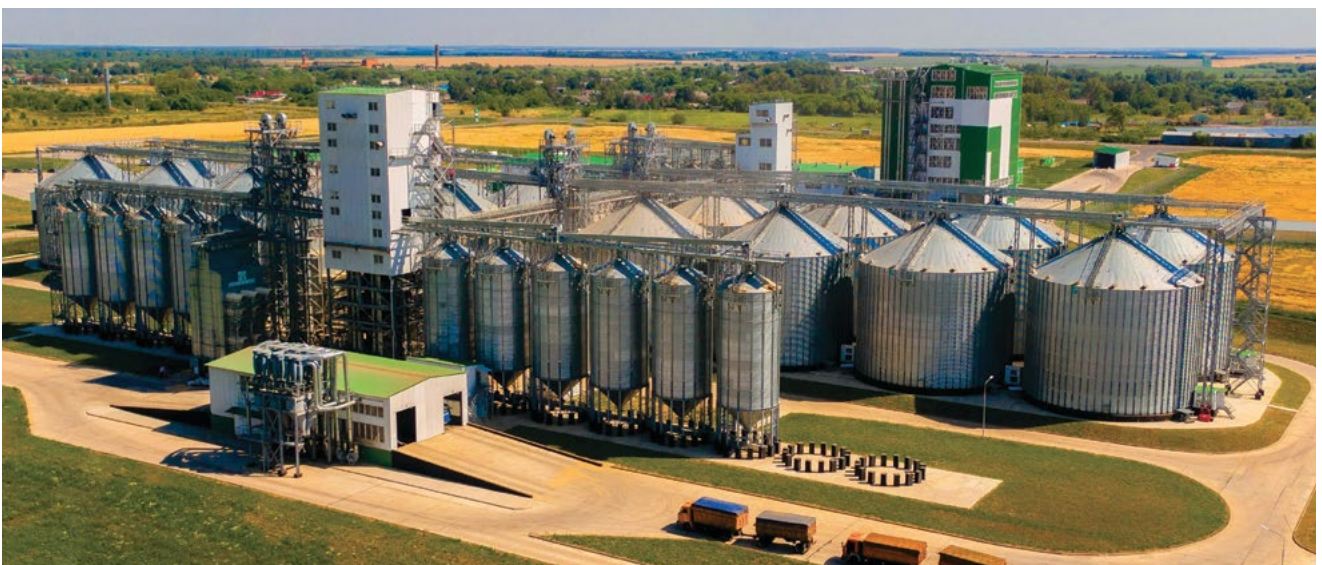
ЭЛЕВАТОРНЫЙ КОМПЛЕКС (ККЗ) ДО 127 000 ТОНН «ТМК», Тульская обл., с. Куркино
